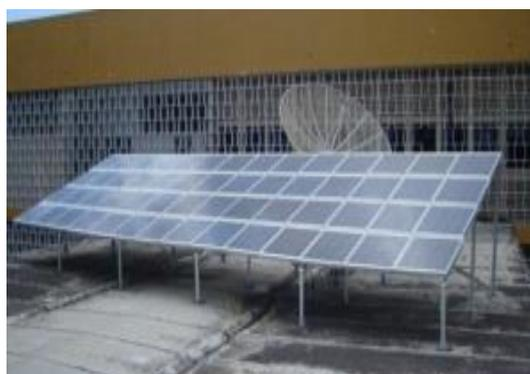
**FIGURA 4 - Painéis fotovoltaicos**
