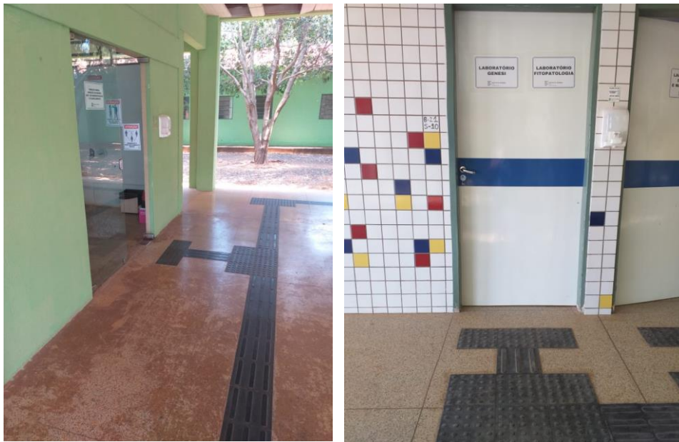
Figura 12 - Guia direcional para cegos do Campus Uruçuí
