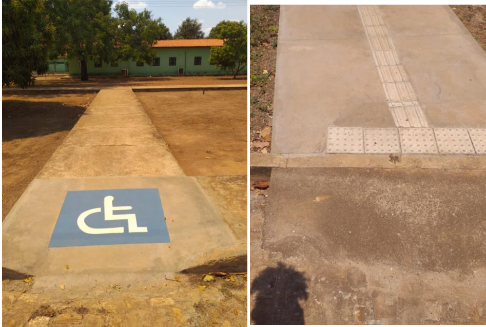
Figura 11 - Rampas do Campus Uruçuí
