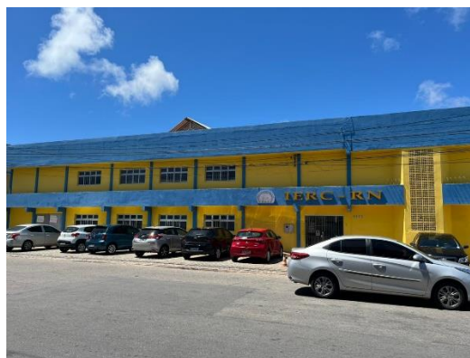
Figura 1- Sede do Instituto de Cegos do Rio Grande do Norte (IERC-RN)
