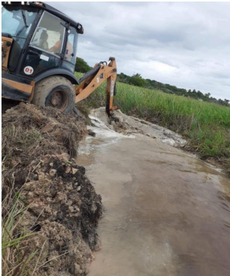
Figura 7: em 2021 a prefeitura desobstruindo valas de escoamento da água pluvial. A prefeitura todos anos desobstrui as valas para ocorrer escoamento das águas pluviais, mas a velocidade que os moradores e outros tamponam está valas por é maior ou seja para reter a água e não inundar seu terreno ou para fazer um acesso sem colocar um tubo de escoamento ou até mesmo fazer uma ponte e pontilhão para deixar o caminho natural de escoamento das águas pluviais chegar até a Praia do Saco.
