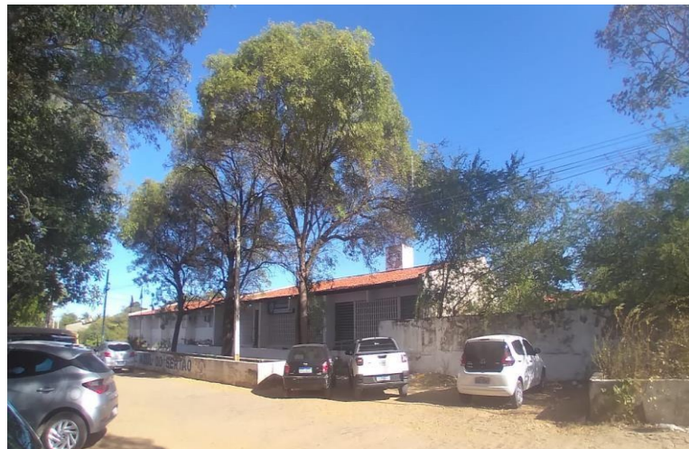
Figura 1 - Frente do edifício atual da Escola Nicéa Claudino
