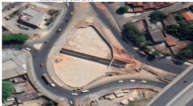
Fig. 4 – Vista aérea da caixa de captação na Avenida Vilarinho, em BH
