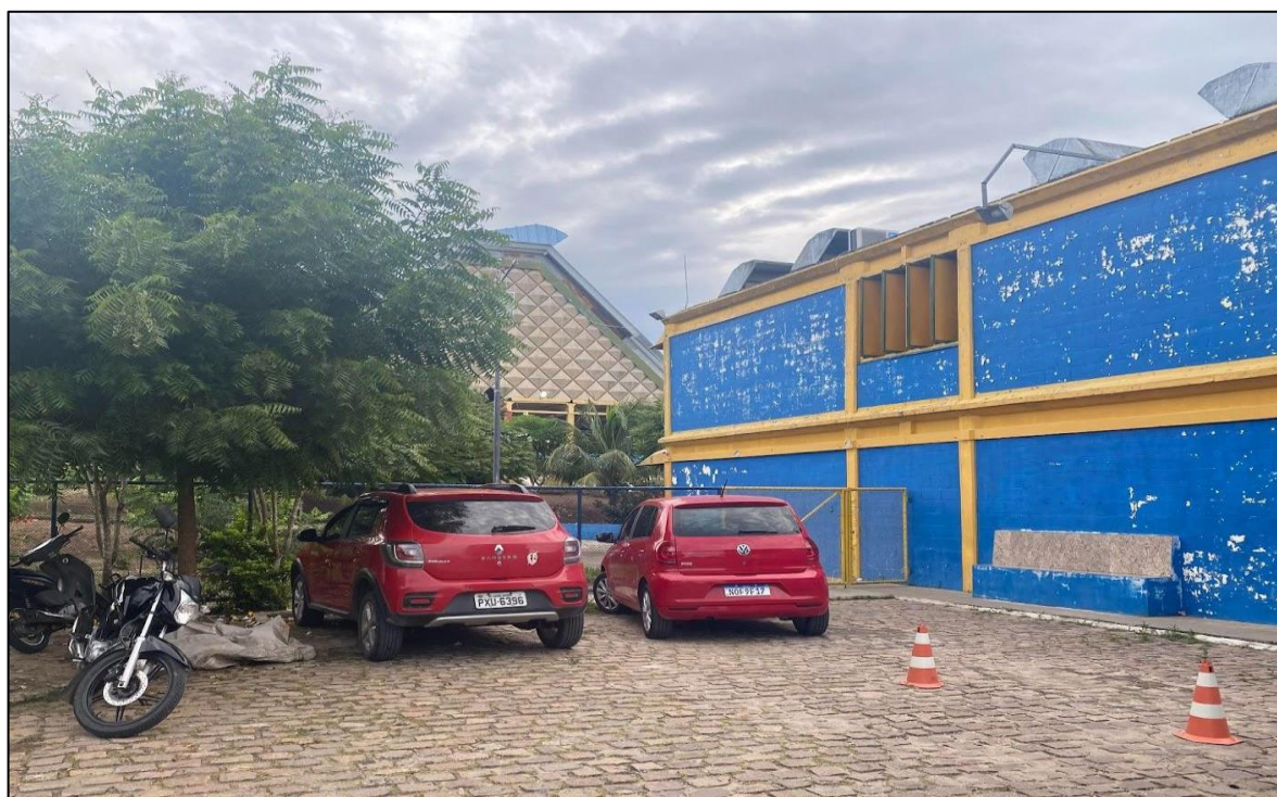
Figura 1 - Fachada da Escola
