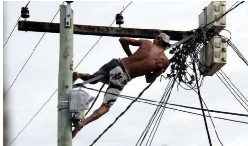
Figura 4: Homem fazendo ligação clandestina em poste.
