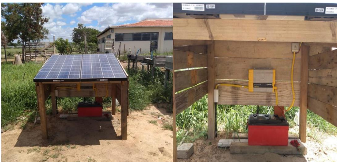
Imagem 1: Sistema Fotovoltaico para abastecer um Sisteminha da Embrapa
