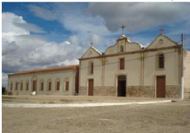
FOTOGRAFIA 6: CASA DE CARIDADE DE PARARI (POMBAS)
