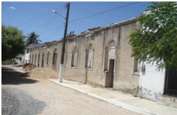
FOTOGRAFIA 9: CASA DE CARIDADE DE SANTANA DO ACARAÚ
