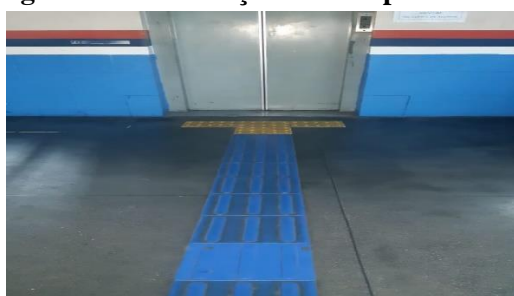
Figura II- demarcação tátil no piso
