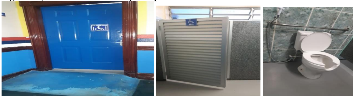
Figura III, IV e V- Banheiro adaptado para usuários de cadeira de rodas
