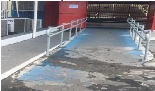
Figura VI- Rampa de acesso
