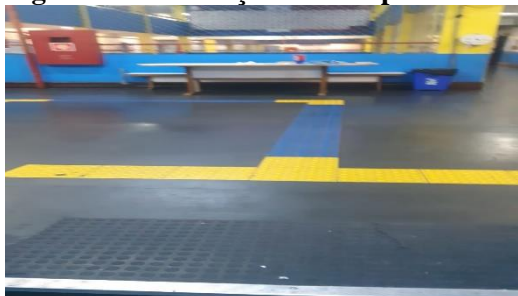
Figura I- demarcação tátil no piso
