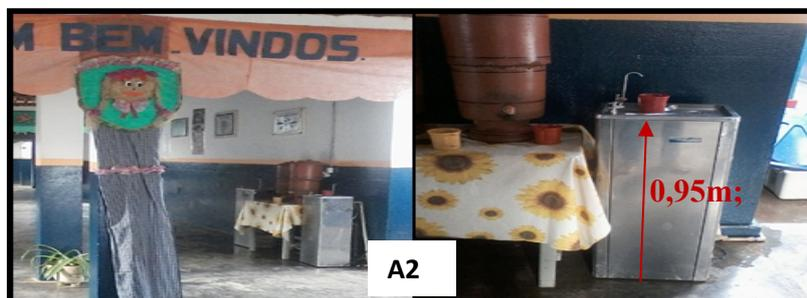
**Figura 4.** Falta de acessibilidade nos bebedouros
