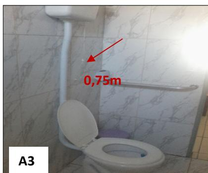
**Figura 7.** Descarga colocada na altura incorreta.
