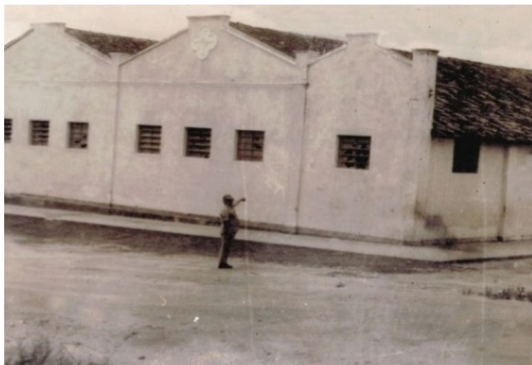
Figura 1- Escola Paroquial São José antes da reforma.
