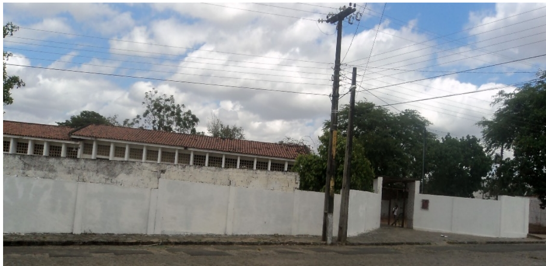
Figura 01 - Entrada da Escola Antônio Oliveira
