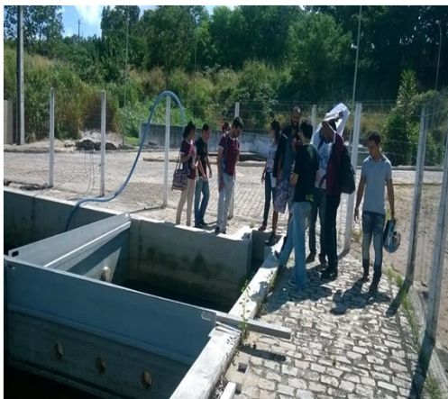
Arquivo pessoal: fotos tiradas na visita a Estação de Tratamento da UFRN.
