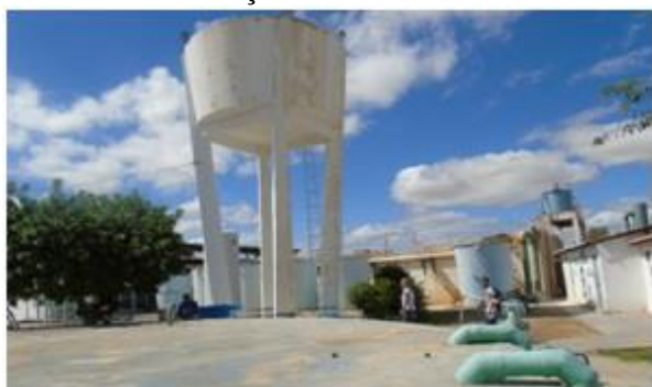
Figura 05: O armazenamento interno e distribuição da ETA.
