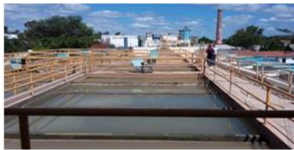
Figura 03: Estação de tratamento de água Convencional.
