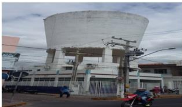
Figura 06: O armazenamento e distribuição Externa da Água.
