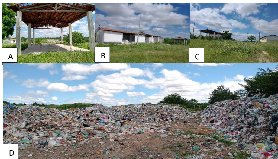
Figura 4: Infraestrutura do aterro controlado do município de São José do Sabugi - PB
