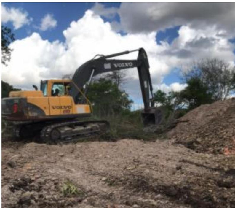
Figura 3 – Escavadeira hidráulica realizando desmatamento.
