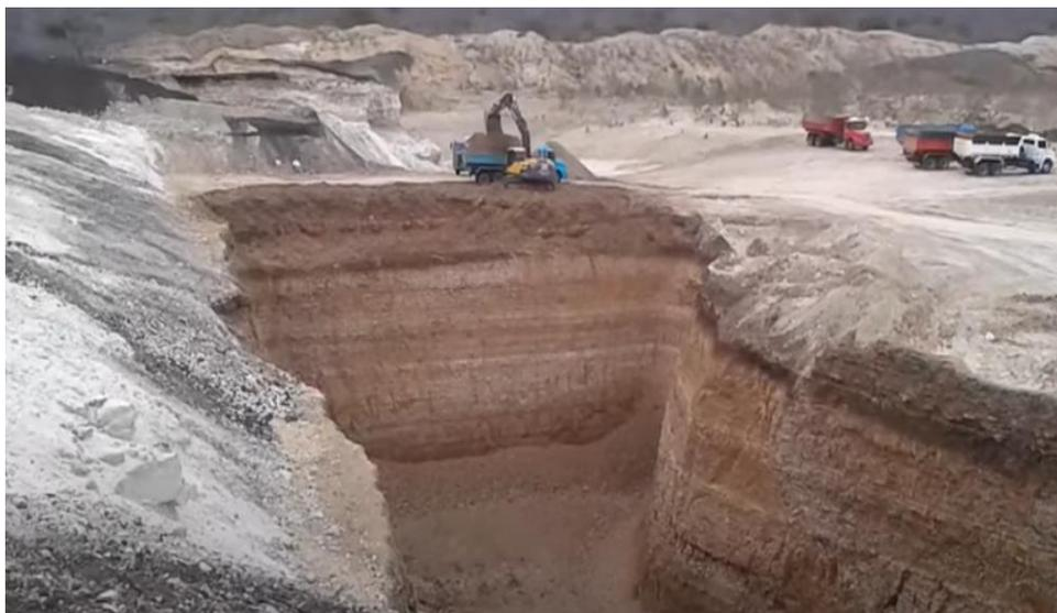
Figura 1 – Operação de carregamento e transporte de argila.
