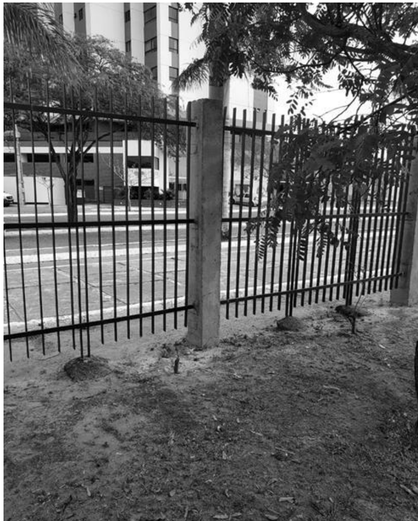
Figura 6: resultado final do pilar recuperado (fonte do autor)
