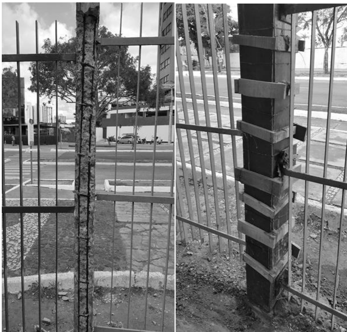
Figura 5: a) demolição e limpeza da armadura, b) montagem das formas para posterior concretagem
