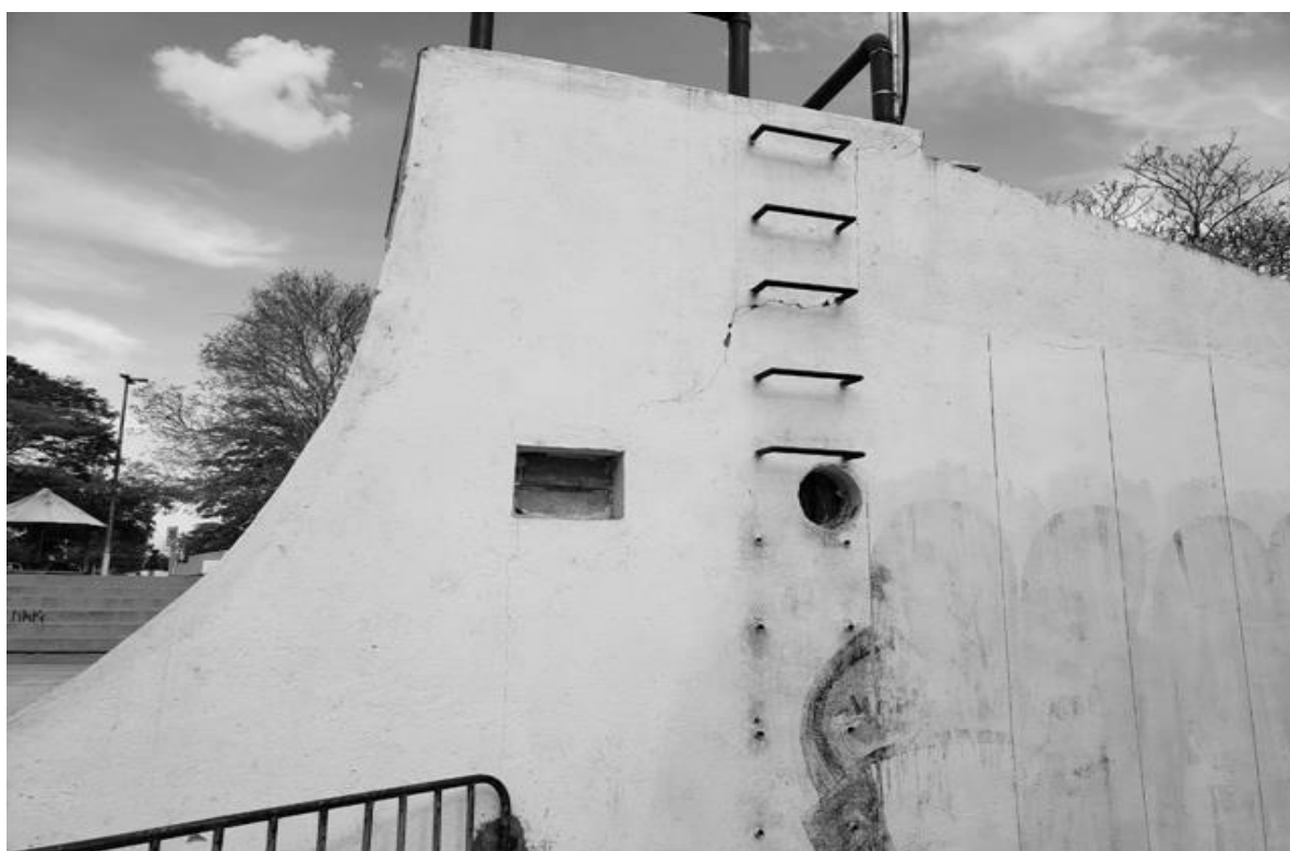
Figura 4: resultado final da parede após a sua recuperação (fonte do autor)
