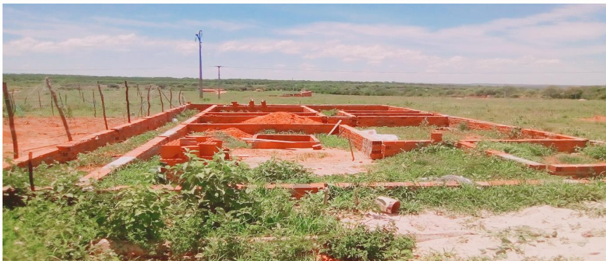
Figura 02 - Casa em processo de construção.
