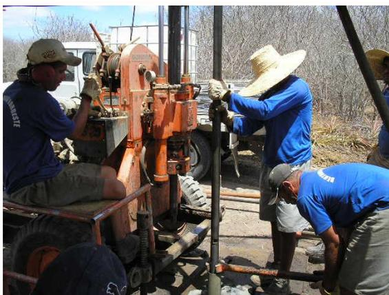
Figura 2 – Retirada das hastes de perfuração.
