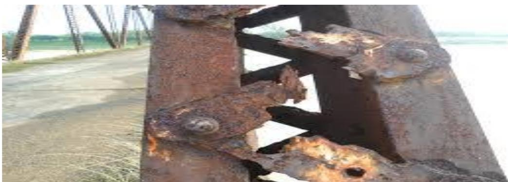
Figura 17: corrosão nas estruturas de aço.
