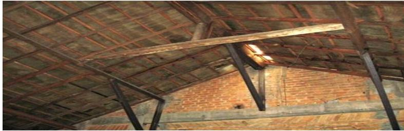
Figura 4: Tesoura metálica em corrosão.
