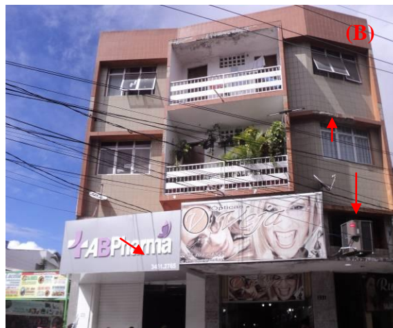
Figuras 7 e 8 - (A) Fachada predial com patologias na Rua Barão do Abiai e (B) Sobrecarga em marquise na Rua Peregrino de Carvalho.
