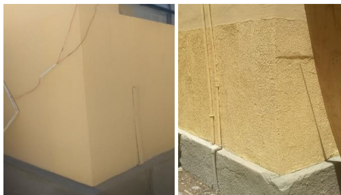
Figura 8: Pilar 1 e 2 recuperado
