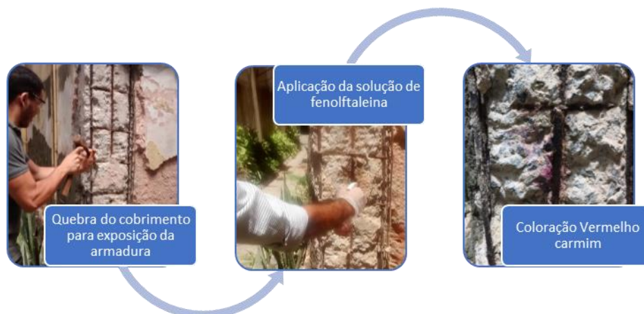
Figura 3: Esquema de realização do ensaio de Profundidade de Carbonatação
