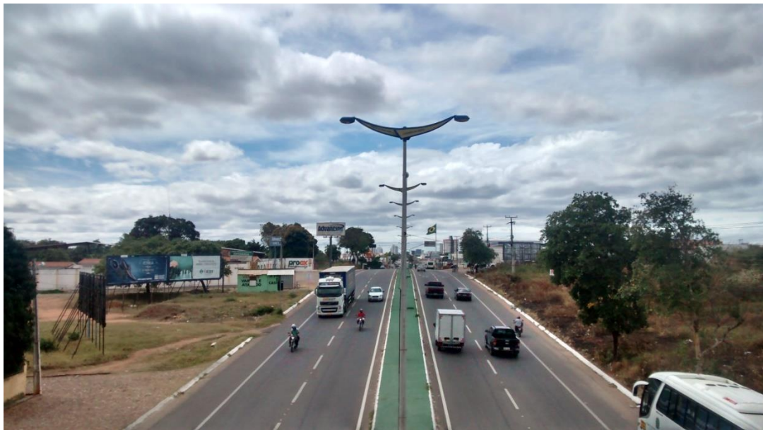
Figura 4 – Rodovia CE-292, em direção à Juazeiro do Norte. Vista do alto da passarela.
