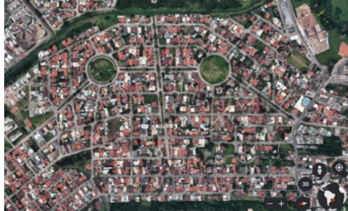
Figura 4: Loteamento Jardim Anchieta, Córrego Grande, Florianópolis.
