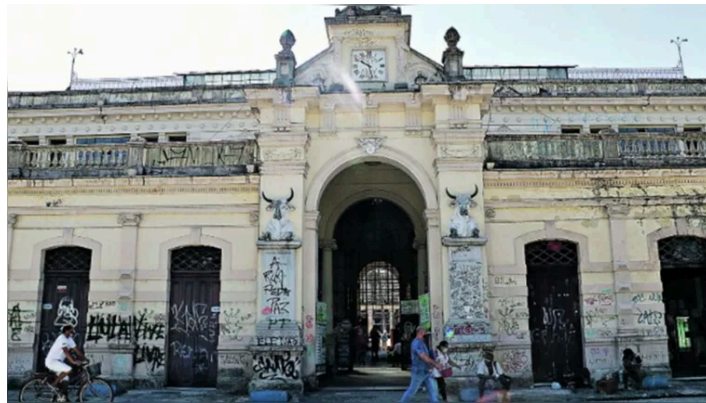
Figura 6: Aspecto da entrada principal do Mercado de São Brás em 2023, observando-se a falta de conservação do edifício e ausência de público.
