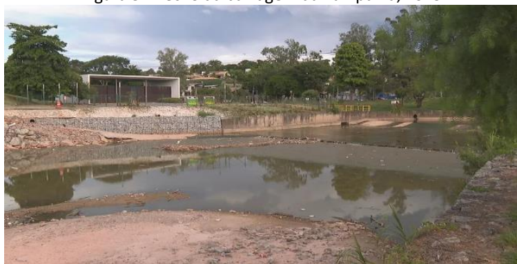
Figura 3: Trecho da barragem da Pampulha, 2023.
