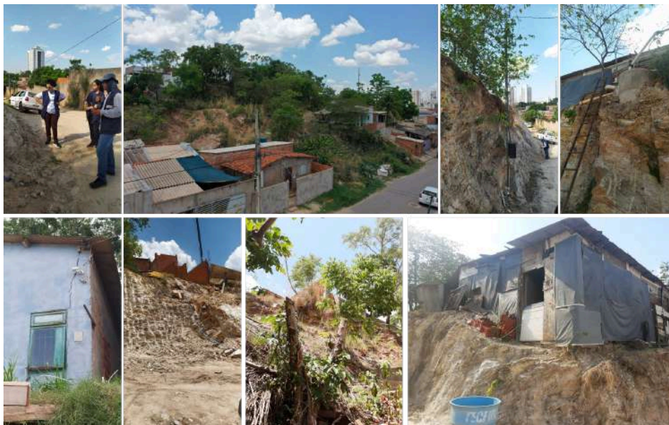
Figura 5 - Alto da Boa Vista - Equipe de Urbanismo e Geoambiental Realizando Demarcando as Áreas de Risco nos Cortes nos Morros para Implantação de Obras Viárias.
