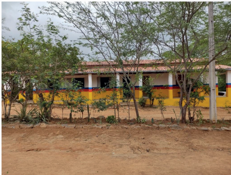
Figura 1 – Pavilhão de salas
