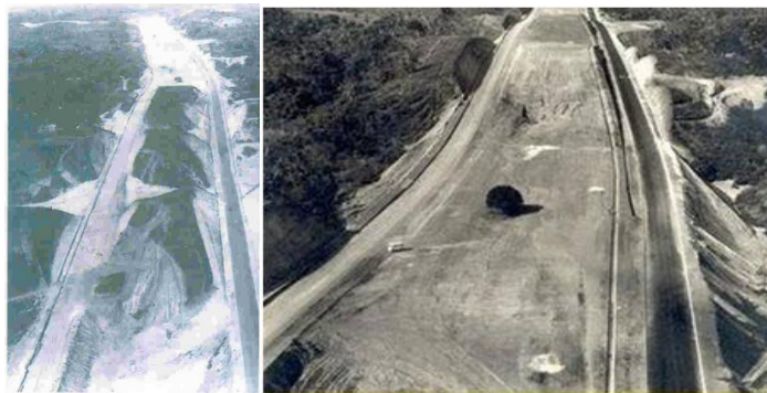
Figura 01 - Imagens da construção da Av. Paralela, fonte (pesquisadas no Google)
