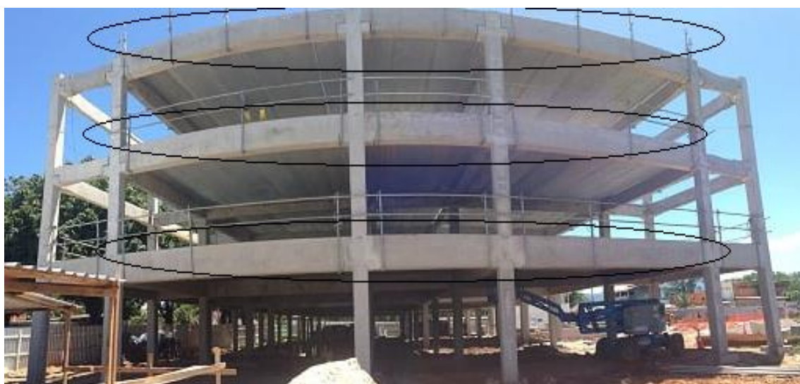
Figura 02 – Vigas pré-fabricadas na obra do projeto Escolas do Amanhã. Fonte: Autores (2015).
