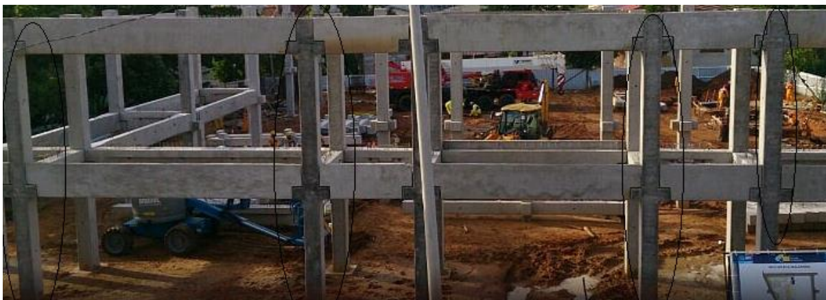
Figura 01 – Pilares pré-fabricados na obra do projeto Escolas do Amanhã. Fonte: Autores (2015).
