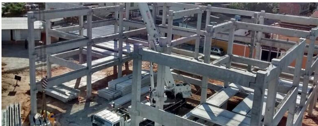
Figura 04 – Canteiro de obras limpo utilizando Estruturas pré-fabricadas na obra do projeto Escolas do Amanhã.
