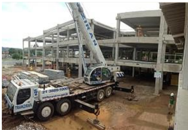
Figura 05 – Necessidade de utilização de transporte no canteiro de obras utilizando Estruturas pré-fabricadas na obra do projeto Escolas do Amanhã. Fonte: Autores (2015).
