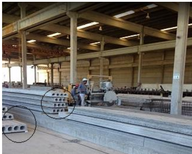
Figura 03 – Lajes alveolares pré-fabricadas na obra do projeto Escolas do Amanhã. Fonte: Autores (2015).
