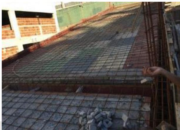
Figura 2 – Rampa de acesso com utilização de plasterit .
