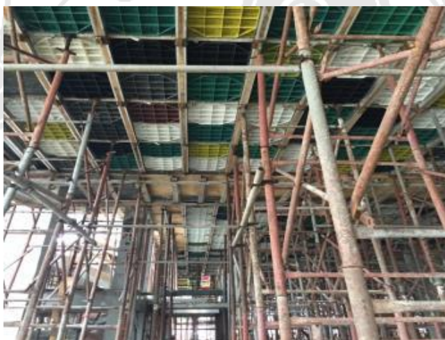
Figura 1 – Cimbramento com utilização de estrutura metálica e plasterite.
