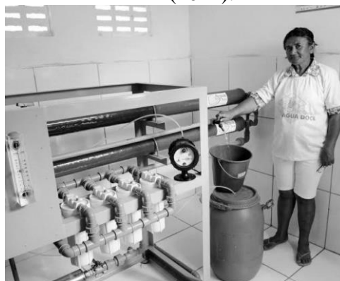
Figura 3. Sistema de dessalinização do Programa Água Doce no estado da Paraíba. Fonte: PAD (2014).
