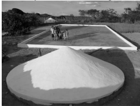
Figura 2. Cisterna calçadão no Semiárido paraibano. Fonte: ASA (2017).
