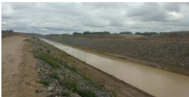
Figura 2: Margens do canal.
