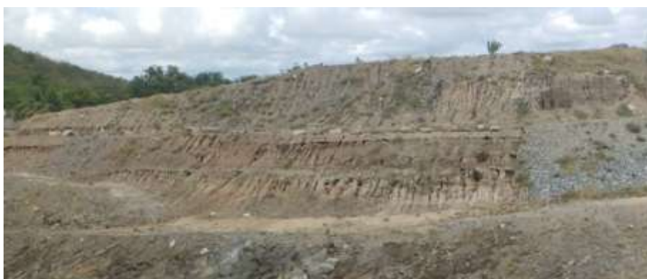
Figura 3: Erosão causada pelo processo de escavação no trecho da transposição.
