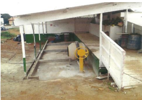
Figura 5 – Setor das betoneiras.
