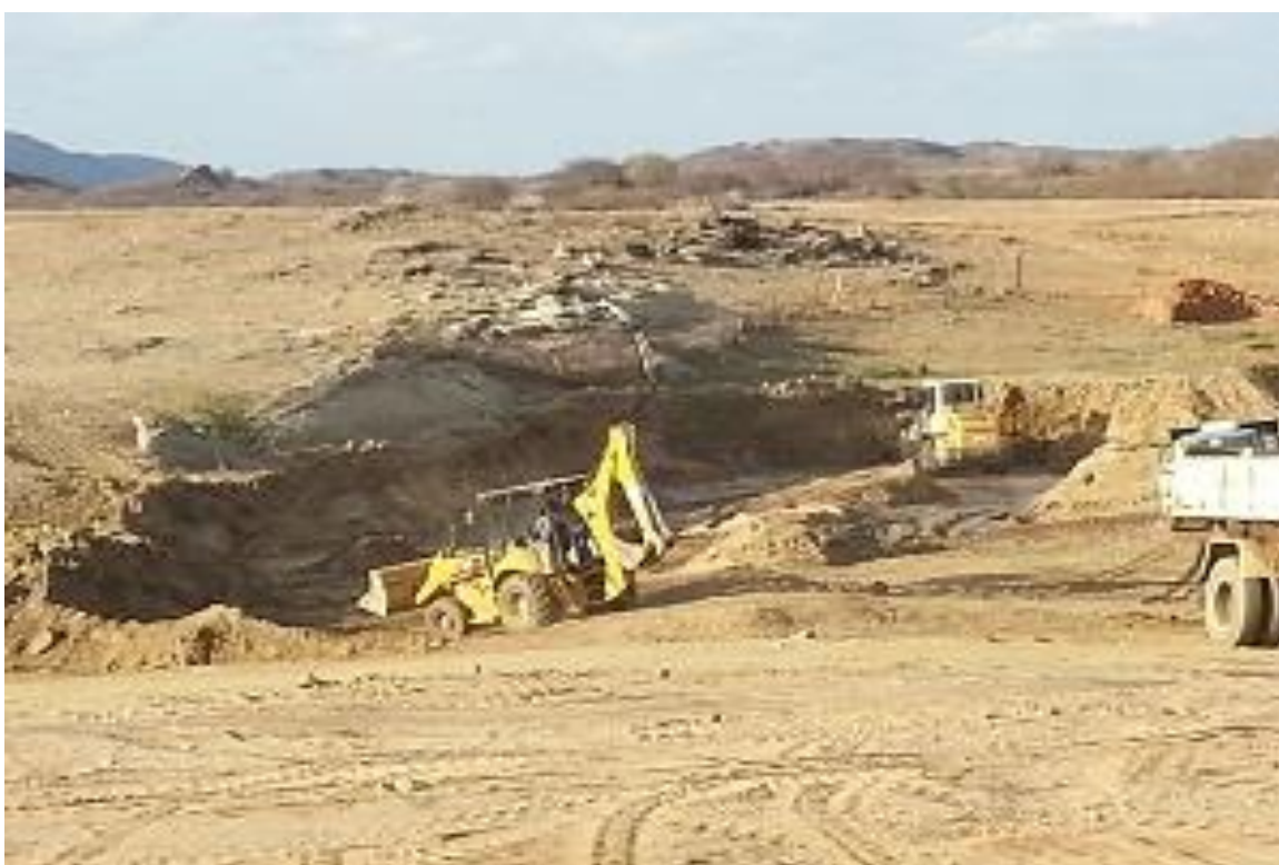
FOTO 02: Retroscavadeira e máquina pá enchedeira retirando sedimentos do leito do açude.
