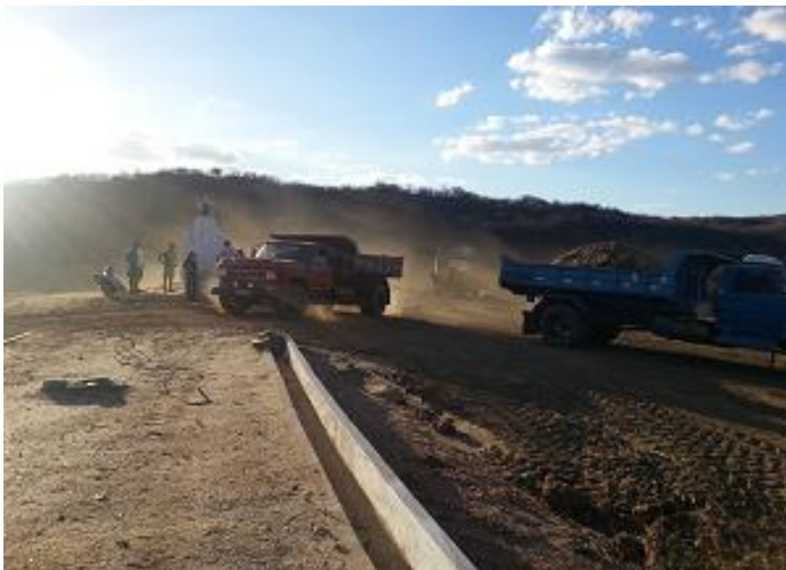
FOTO 03: Caminhões caçambas transportando material e depositando na parede oposta ao açude, fortalecendo a mesma para um possível aumento de sua capacidade.
