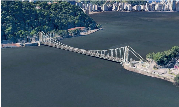
Figura 10 - Ponte Pênsil de São Vicente
