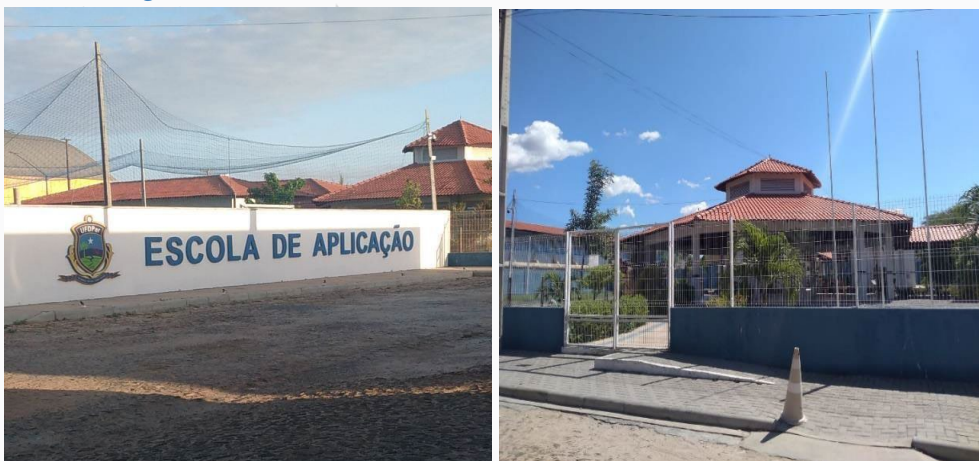
Figura 3 e 4: Foto das atuais instalações da Escola de Aplicação
