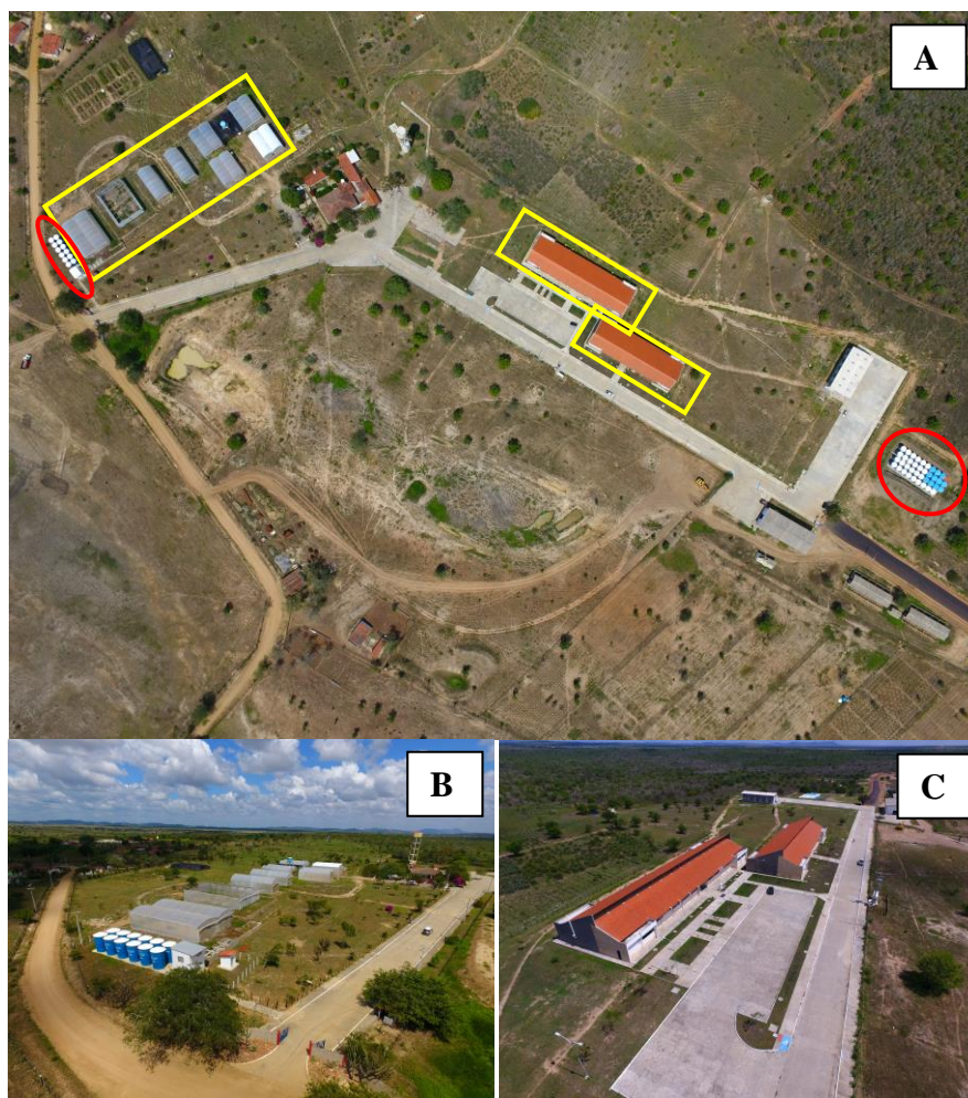
Figura 1 – Imagem aérea dos sistemas de captação (retângulos em amarelo) e armazenamento (círculos em vermelho) das águas pluviais (A); Detalhes do sistema instalado próximo às estufas (B) e da superfície de captação (telhados) dos prédios laboratoriais (C). Fotos: Felipe Lavorato (INSA).
