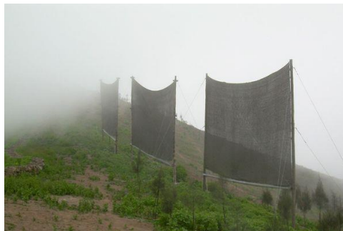
Figura 3: captação de água através do fog-catchers
