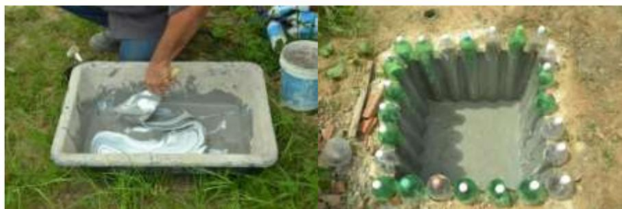
Figura 03 – Mistura de cimento e cola para impermeabilização e mini-BET impermeabilizada.
