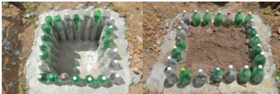
Figura 02 – Mini-BET finalizada e em teste de resistência mecânica.
