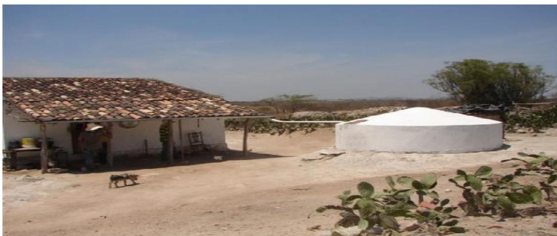
Figura 01 – Cisterna de placa de cimento, construída pelo P1MC. Fonte: Caritas
