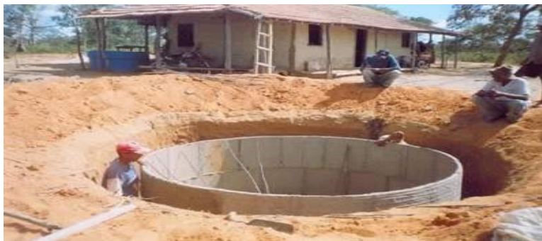
Figura 1: Construção de cisterna em comunidade rural
