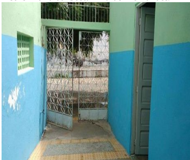
Figura 03: Rampa na entrada da Universidade Pedro Maria da Costa - Rafael Fernandes/RN
