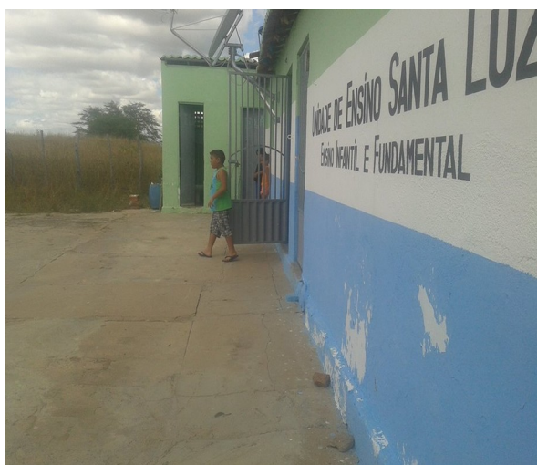
Figura 06: Vista da porta de estrada da escola e de banheiro (ao fundo) na Unidade de Ensino Santa Luzia
