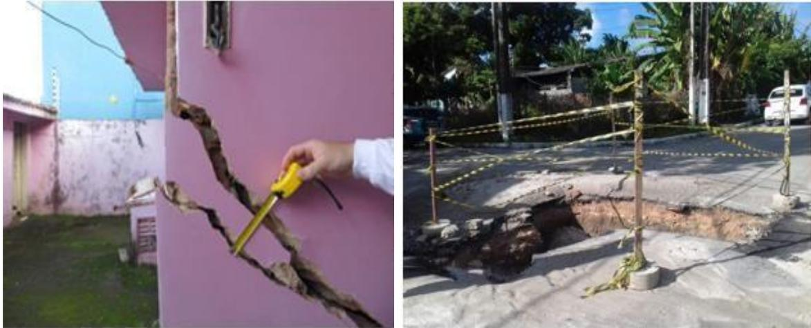
Figura 3 - Trincas nas moradias e problemas no sistema viário causados pelo afundamento do solo na região de Maceió/AL.
