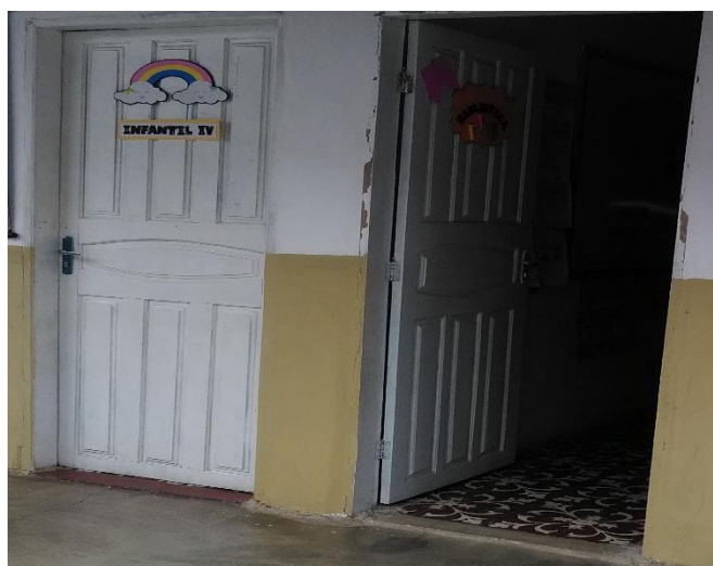
Figura 6- Porta de Entrada das Salas de Aula:
