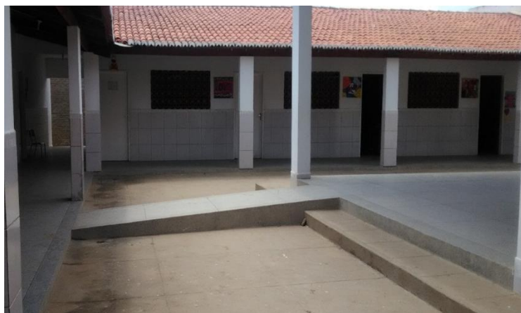
Figura 8- Rampas de Acesso aos Cômodos da Escola: Escola V
