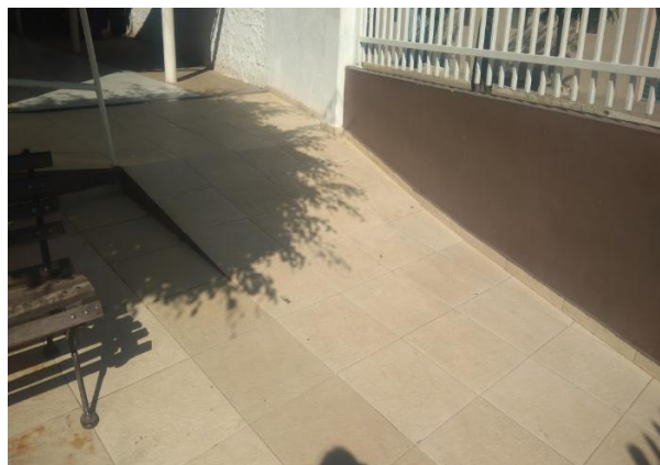
Figura 2- Rampa de Entrada: Escola I
