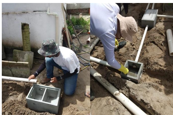
Figura 3: Instalação das caixas de espuma, gordura e inspeção
