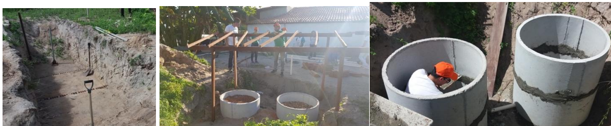
Figura 1: Valas para instalação das fossas biodigestoras e manilhas do bioágua familiar sendo aplicadas
