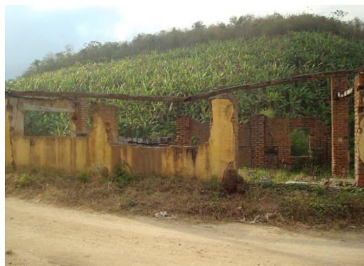
Figura 5: Ruínas do engenho da Volta
