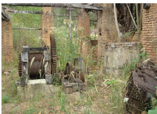
Figura 4: Ruínas do engenho da Tramedal
