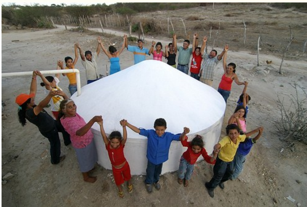
Figura 1. Cisterna de Placas
